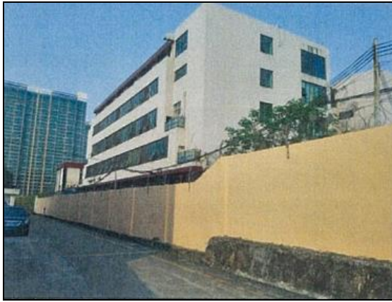
项目东面——南岗商务园
