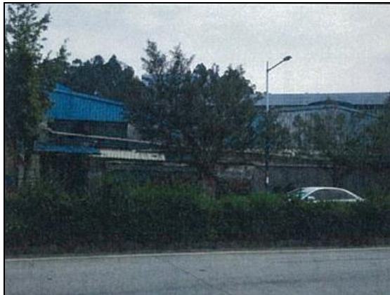
项目西面——教育厅教育印刷厂房
